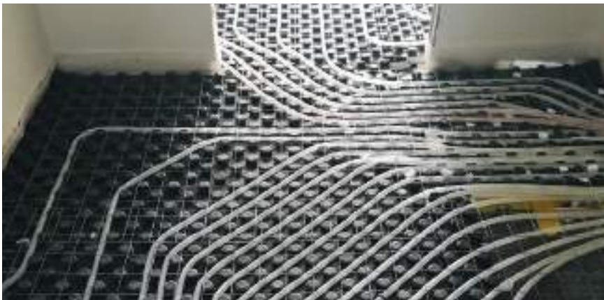
IMPIANTO A PANNELLI RADIANTI A PAVIMENTO
